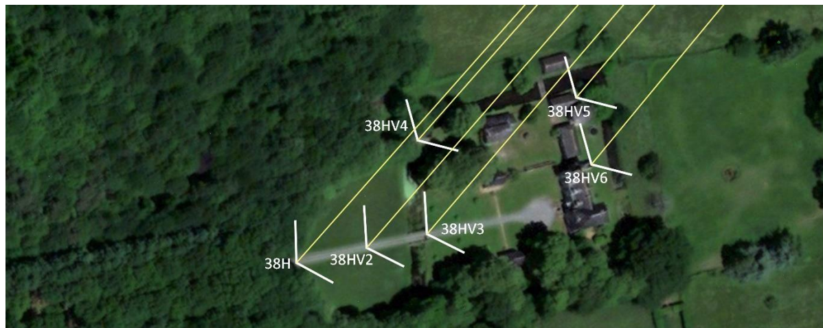
Emplacement des prises de vues du château de Quéhillac et orientation du projet – vue aérienne
