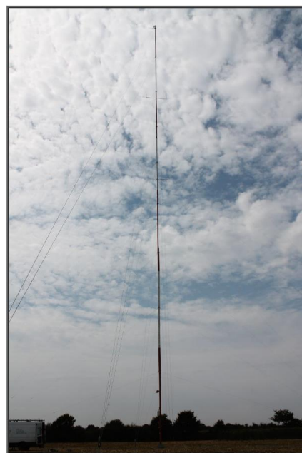
Mât de mesure installé à Bouvron
